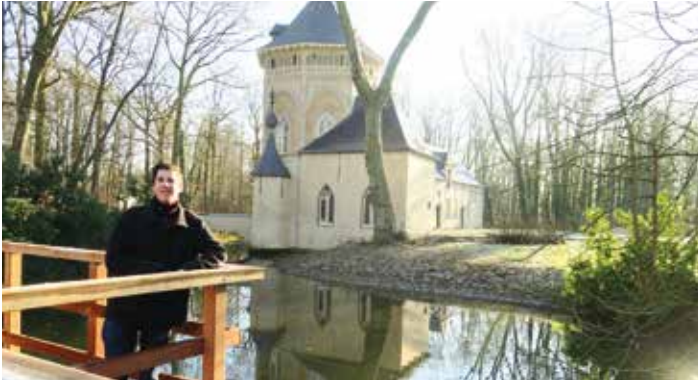
Een kijkbrug in Wijnegem
